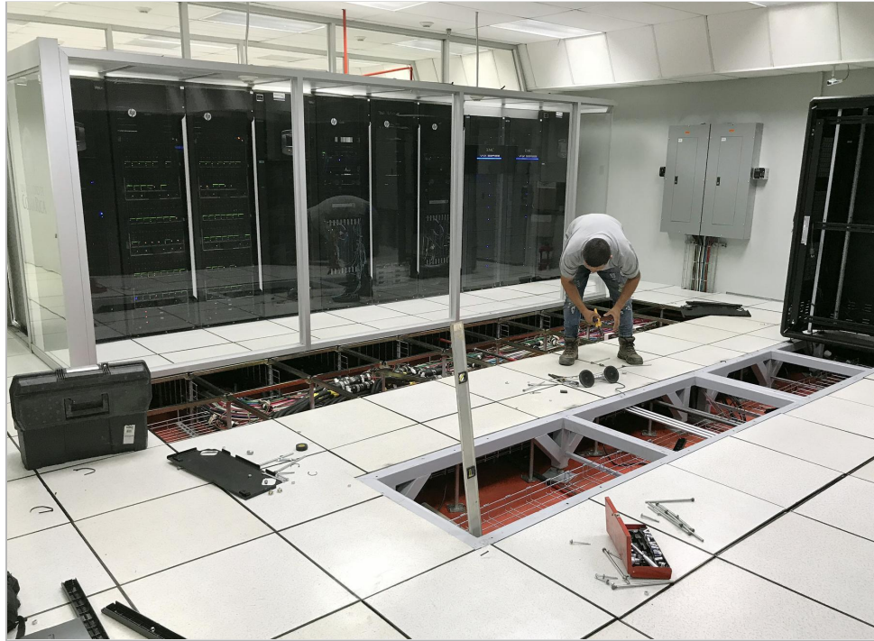
Ilustración 4: Mejoras en el Centro de Datos Institucional
